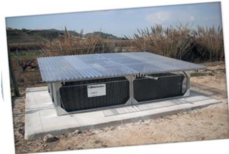
Betonska platforma na kojoj se obavlja punjenje rezervoara prskalice, kao i pranje prskalice nakon obavljene primene.
