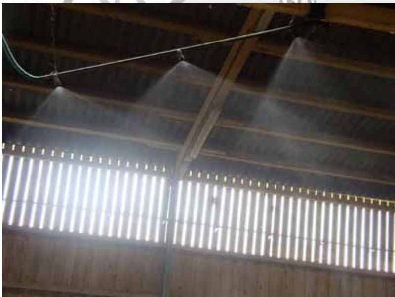
Sl. Br.4. Na plastično crevo priključeno na slavinu priključi se krilo od prskalice sa 1,2,3, ili 4 dizne.
