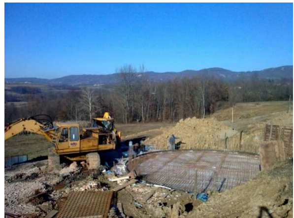
Slika 6. Digestor u izgradnji
